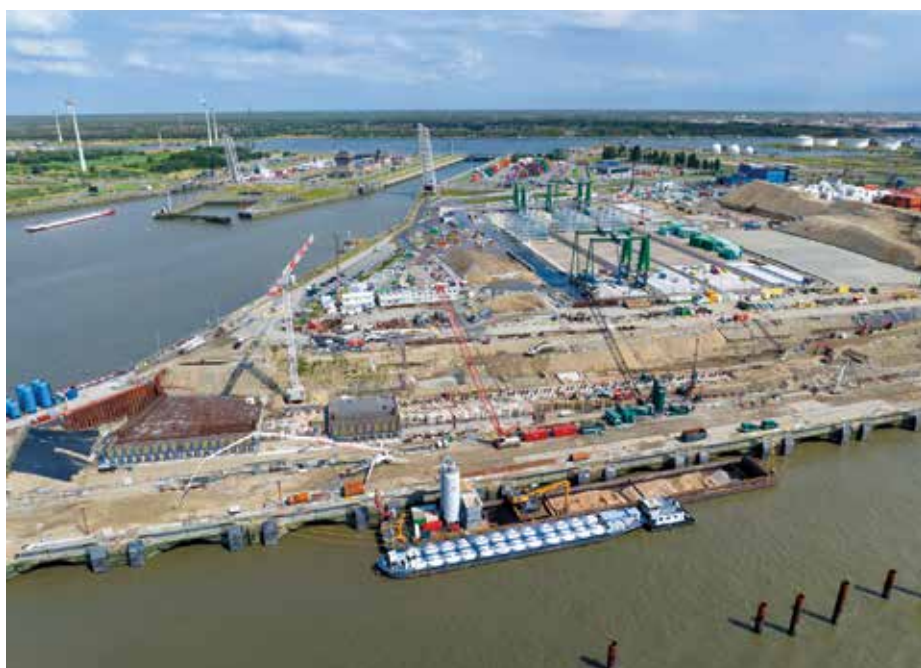
De Contoon wordt momenteel ingezet bij de bouw van de Europa Terminal in Antwerpen.
