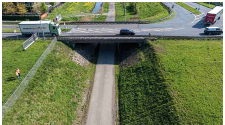
De Uilendijk, waar in fase 1 een extra viaduct over wordt geplaatst om De Entree te verbreden.
