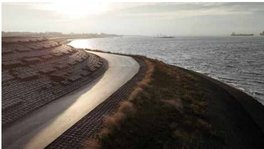
De Dijkversterking in het dorp Hansweert is essentieel om Zeeland bestand te laten zijn tegen de zeespiegelstijging.
