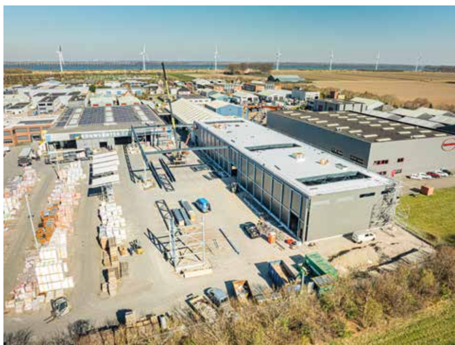
Bouw van een nieuwe loods voor Bouwcenter Esselink in Middelharnis in 2025.
