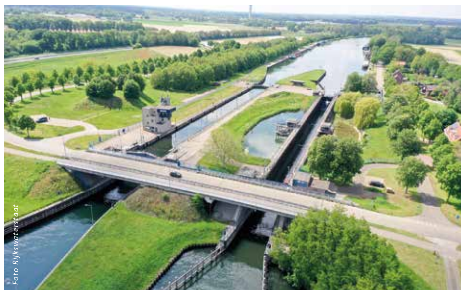
Panheel sluis (Limburg), waar de uitvoeringsfase van Tilburg 3 in oktober 2025 officieel van start is gegaan.
