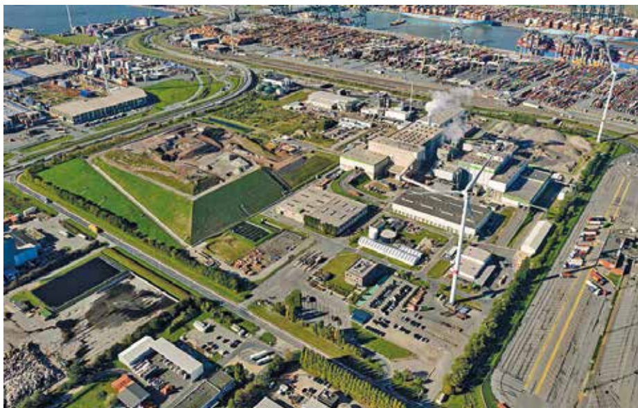
De waste-to-energy installaties van Indaver in Doel.
