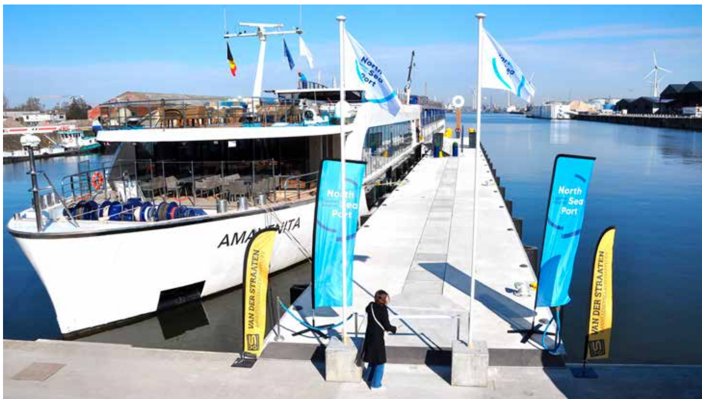
North Sea Port nam vorig jaar in Gent een nieuwe steiger met walstroom voor riviercruises in gebruik. Foto Adri van de Wege
