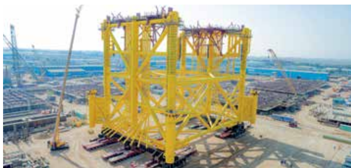
Het offshore jacket werd door Mammoet veilig overgebracht naar het schip.
