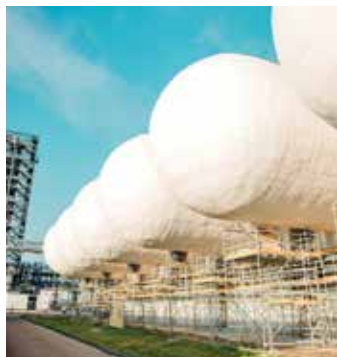
Voor het CCS-project zijn zeven enorme storagetanks gebouwd.
