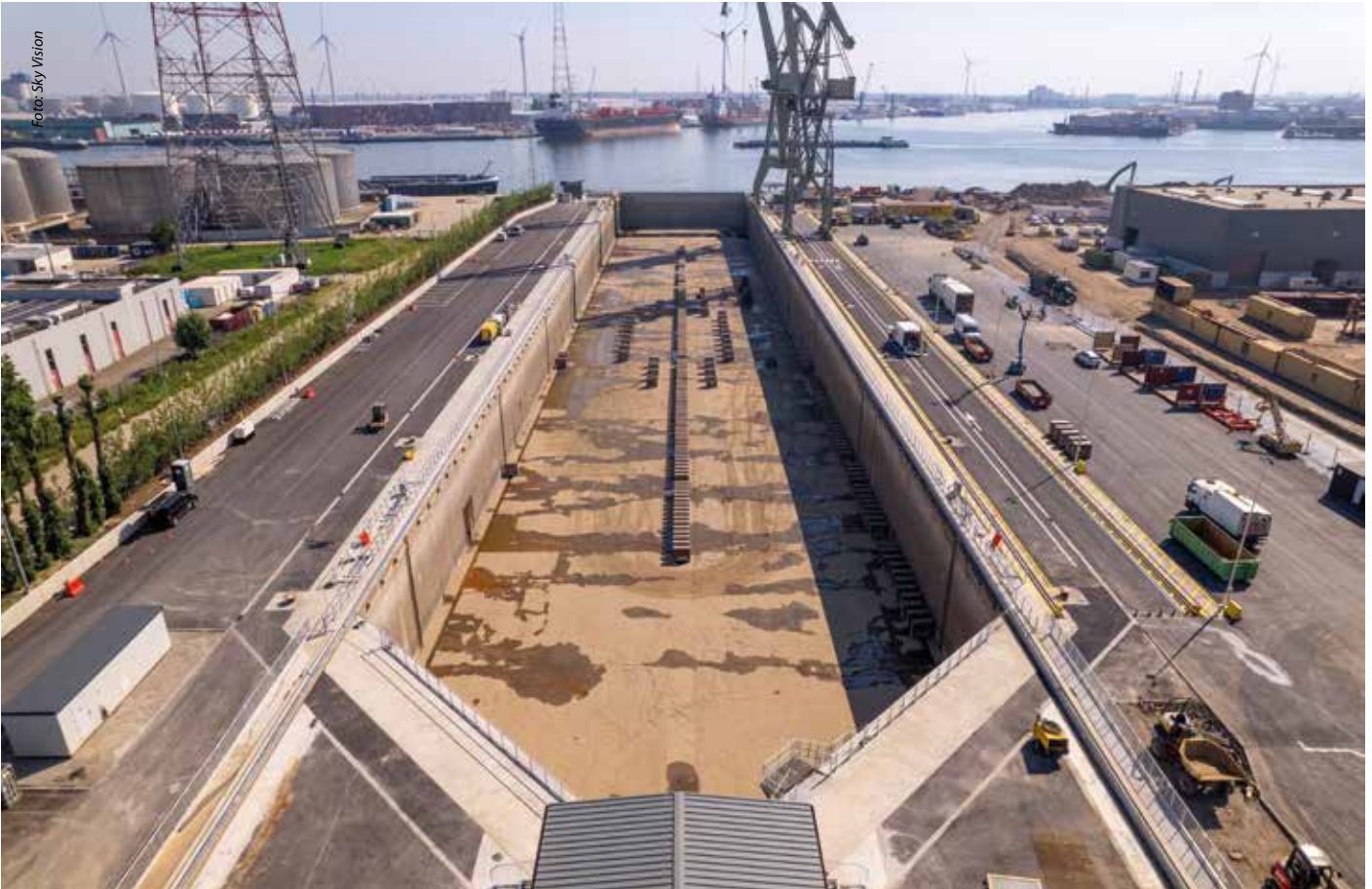
De Antwerpse scheepswerf beschikt in totaal over vier dokken, variërend van 192 tot 312 meter lengte. EDR heeft in de afgelopen jaren Droogdok 5 compleet gerenoveerd.
