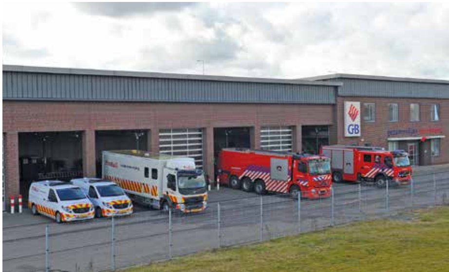
GB kazerne Butaanweg en ProRail ICB.
