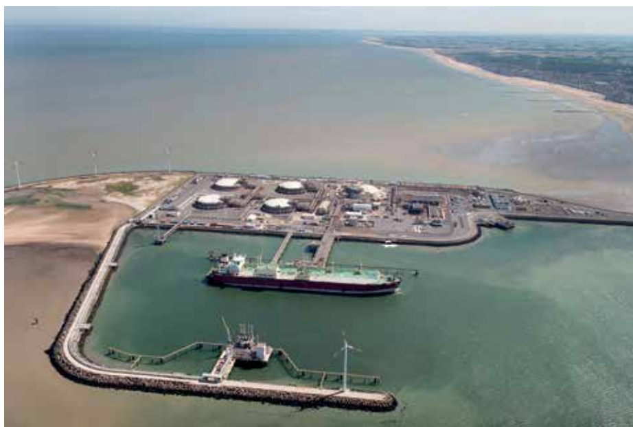
Fluxys LNG Terminal.
