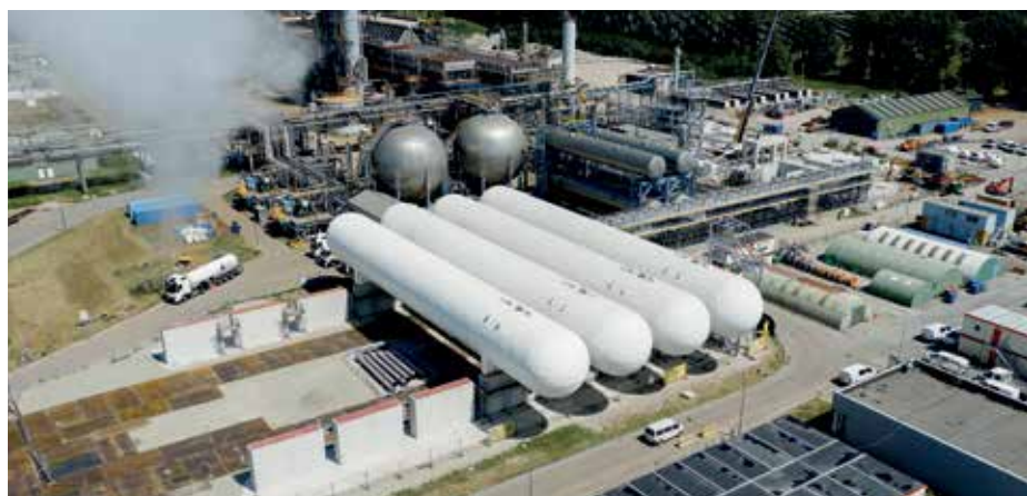
Storagetanks voor het CCS-project.
