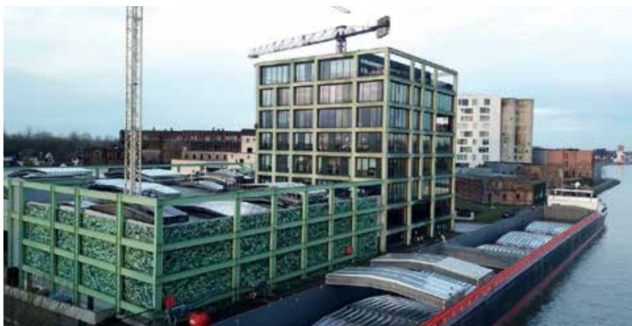
Bovenaanzicht van het hoofdkantoor van Blommaert Aluminium Constructions in Wijnegem.
