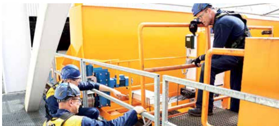
Elmec-servicemonteurs aan het werk bij de 80 tons dubbelligger bovenloopkraan voor SIF Roermond in 2023.
