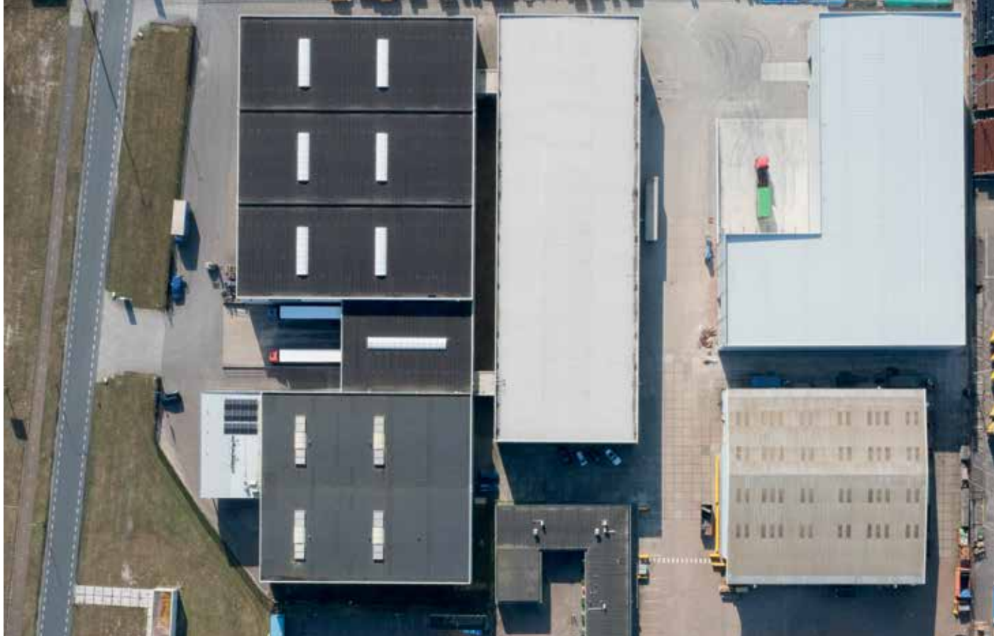
Na een forse uitbreiding in 2019 van het bedrijfsterrein van Pfauth Logistics, is begin dit jaar een nieuwe opslagloods van 2.500 vierkante meter met laad- en losdocks in gebruik genomen.
