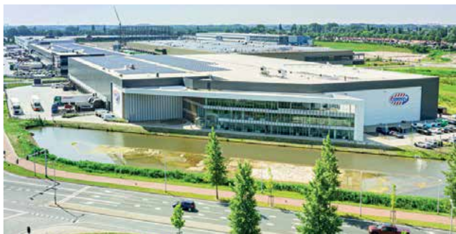
De nieuwe hoofdvestiging van popcorn producent Jimmy's in Ridderkerk werd begin dit jaar in gebruik genomen.
