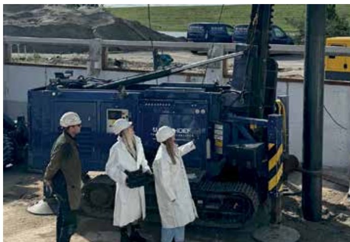
Alice van Muijlwijk (midden) en Janneke van de Graaf slaan de eerste paal van het hoofdkantoor van Baggerbedrijf De Boer.
