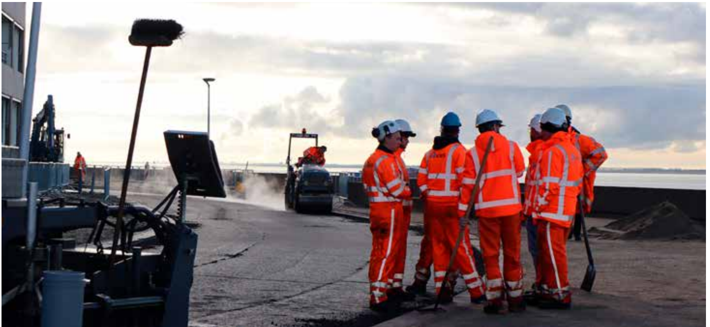
Asfalteren Boulevard Vlissingen.
