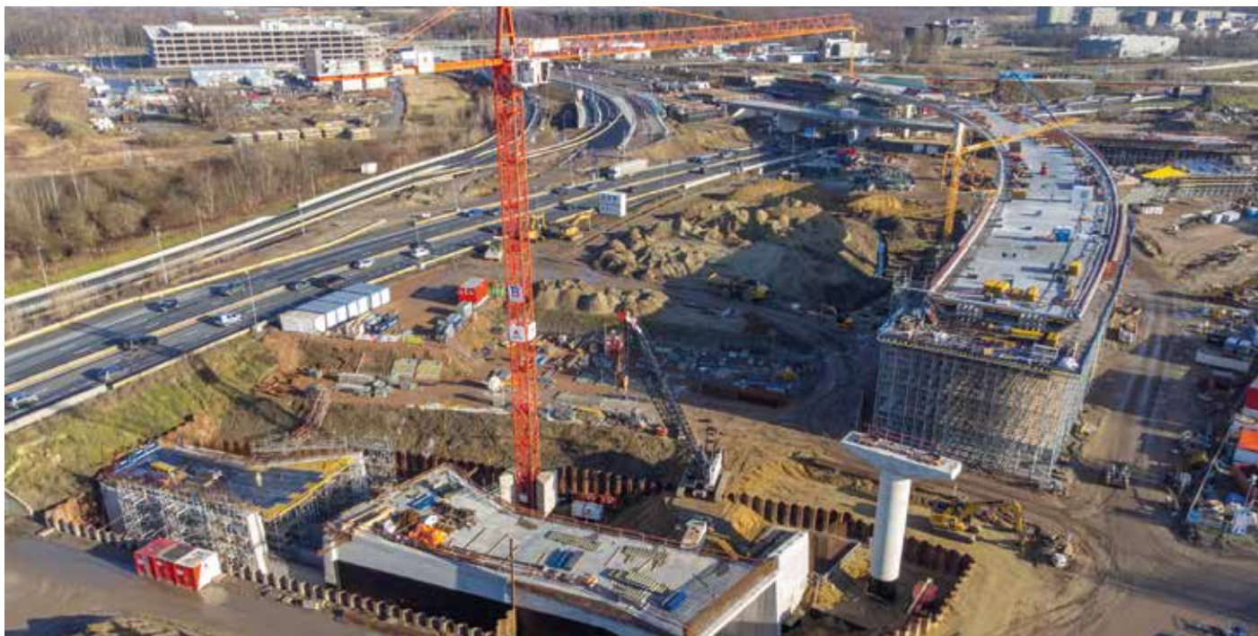
Oosterweelwerken Antwerpen. (foto Lantis)
