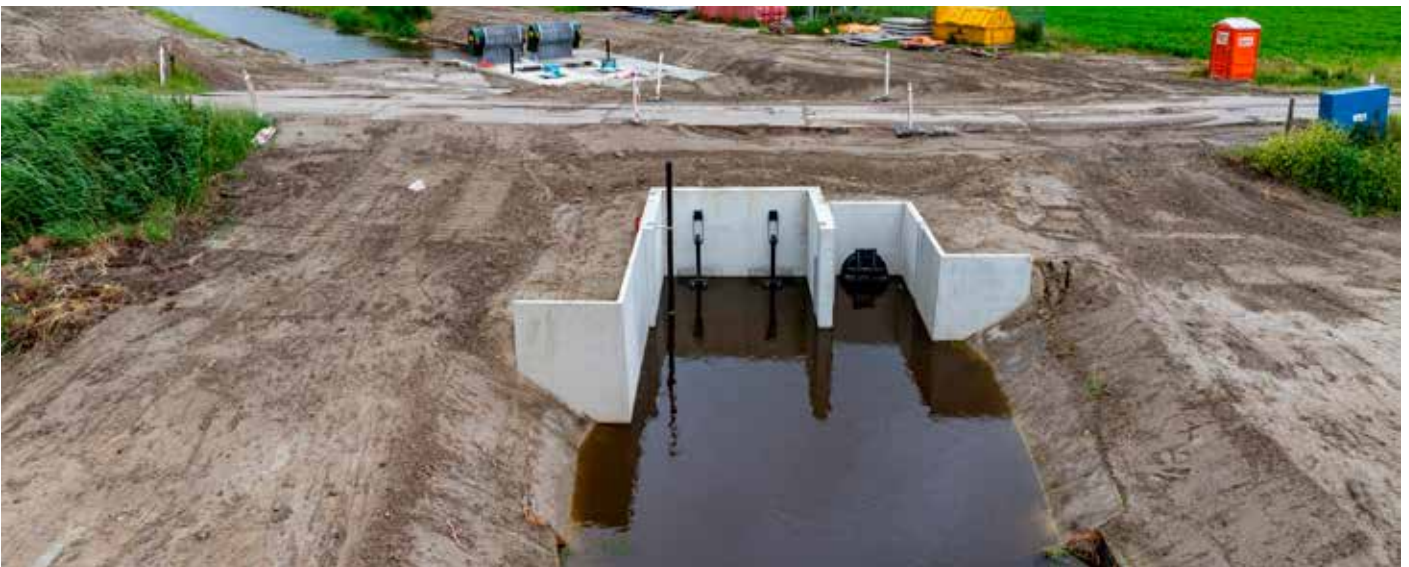
Gemaal Spanjaardsweg Philippine.
