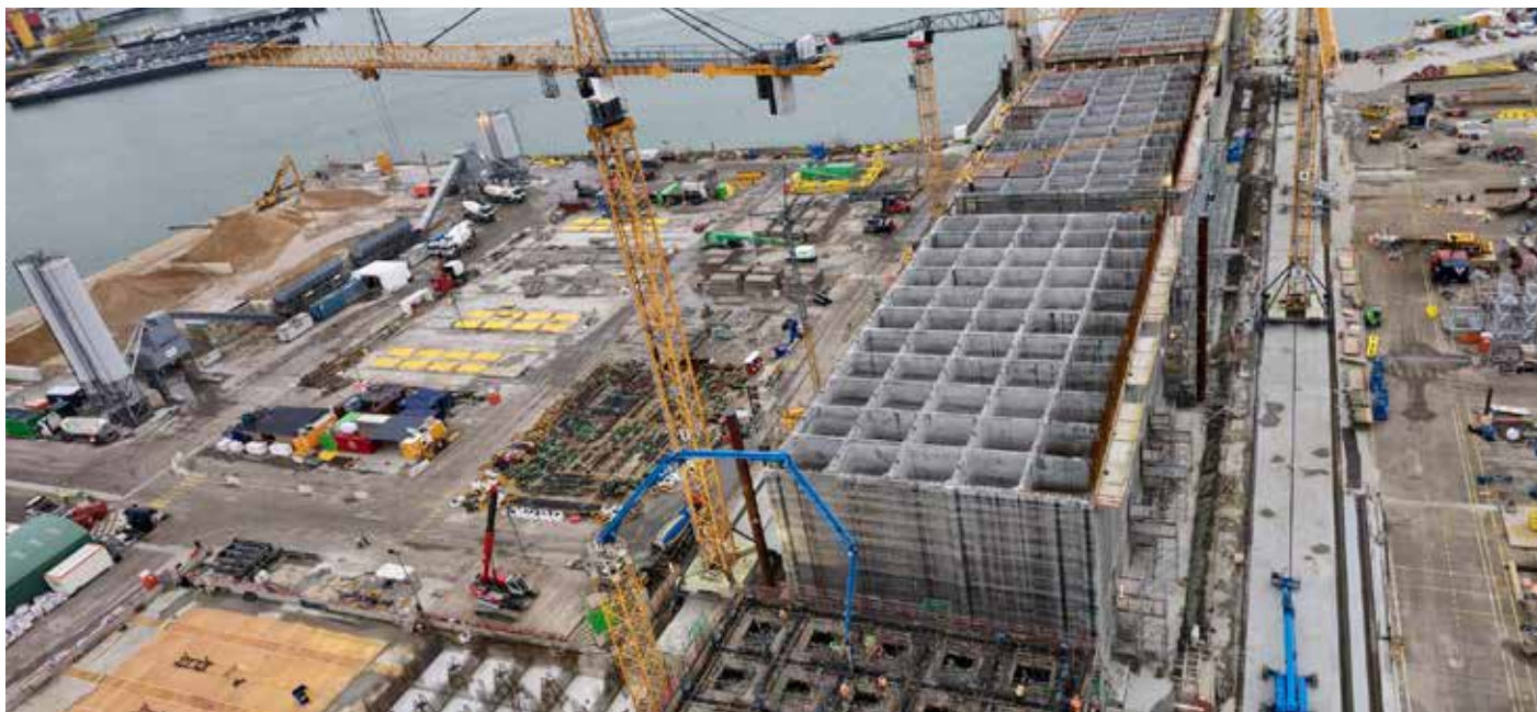
Momenteel heeft De Rycke ook twee centrales on site in Vlissingen, voor de bouw van het nieuwe energie eiland, dat voor de Belgische kust komt te liggen. (foto TM Edison)
