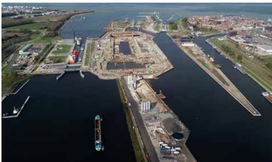
De Rycke had twee werfcentrales in het kader van de Nieuwe Sluis Terneuzen, die officieel geopend is in oktober 2024. (foto TM Sassevaart)
