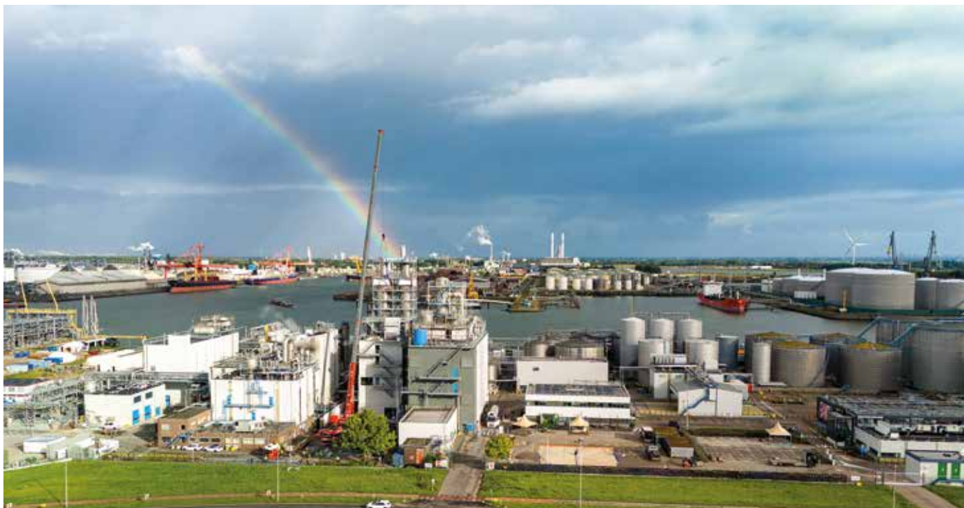
De indrukwekkende nieuwe fabriek van Cargill in Rotterdam-Botlek.
