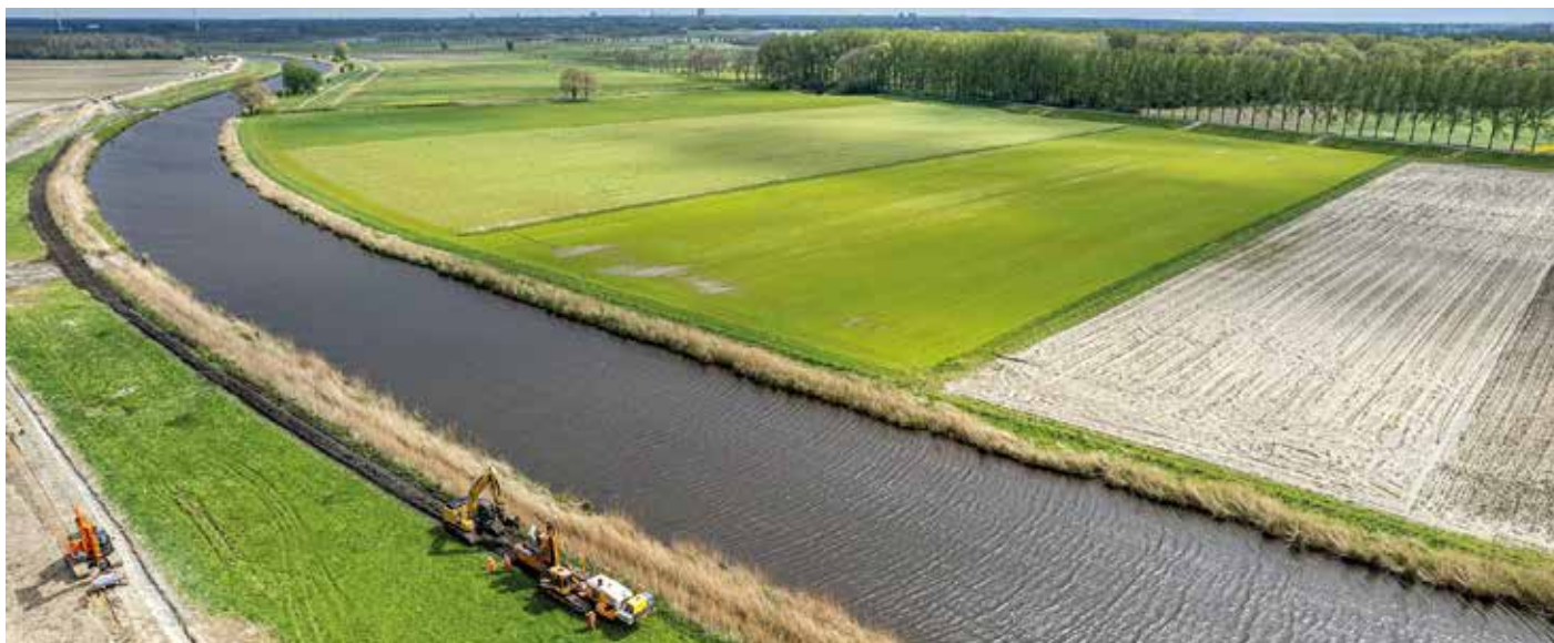
Het plaatsen van beverschermen langs de Mark, Dintel en Vliet door KWS onderneming Gebr. Van Kessel.
