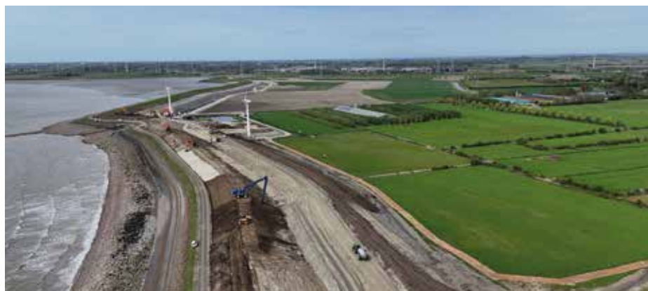
Met het versterken van de dijk in Hansweert wordt voldaan aan de laatste veiligheidsnormen.
