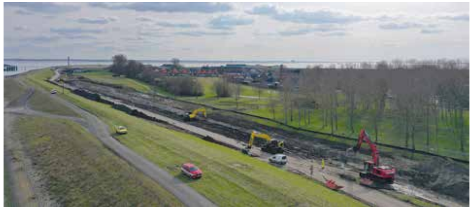
Project Dijkversterking Hansweert.
