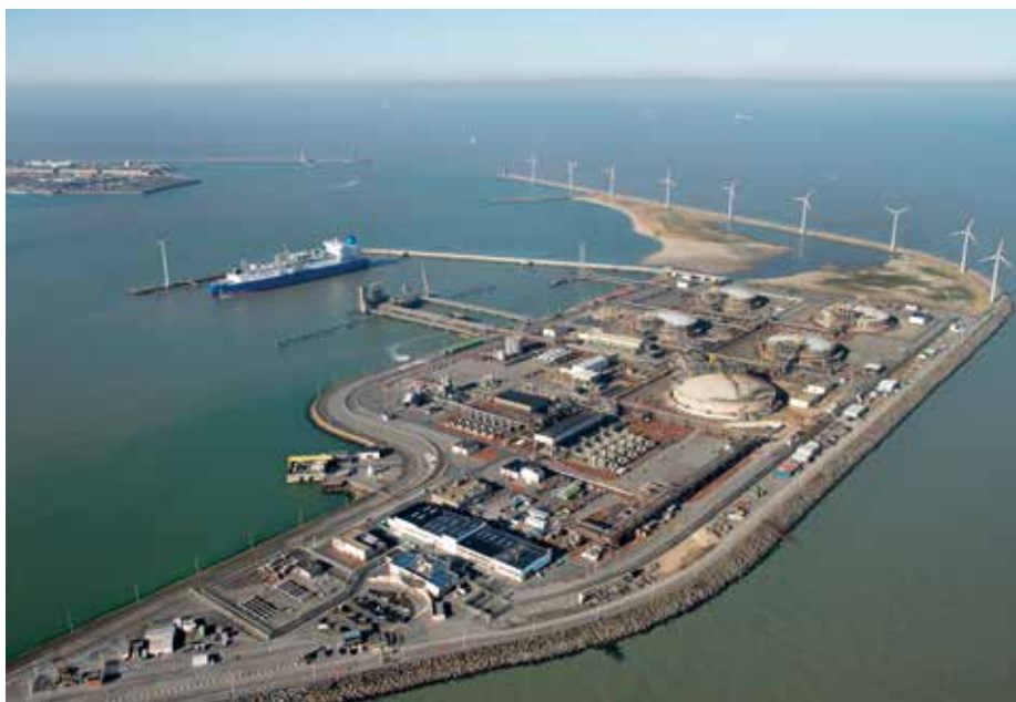
Fluxys LNG Terminal, Zeebrugge.
