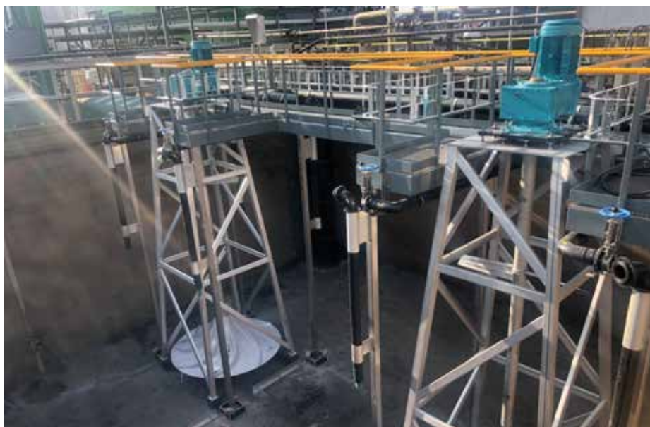
Het MBBR-systeem berust op de werking van carriers ofwel dragermateriaal voor actief slib.
