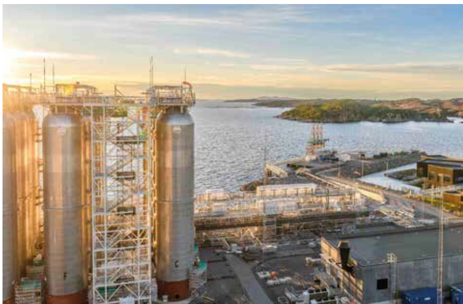
De CO 2 ontvangstinstallatie van Northern Lights in Øygarden. De CO 2 schepen worden hier gelost in opslagtanks. Vervolgens wordt de CO 2 vanuit deze tanks 100 kilometer uit de Noorse kust opgeslagen in lege gashoudende die bestaan uit poreus gesteente op 2,6 kilometer diepte in de zeebodem.
