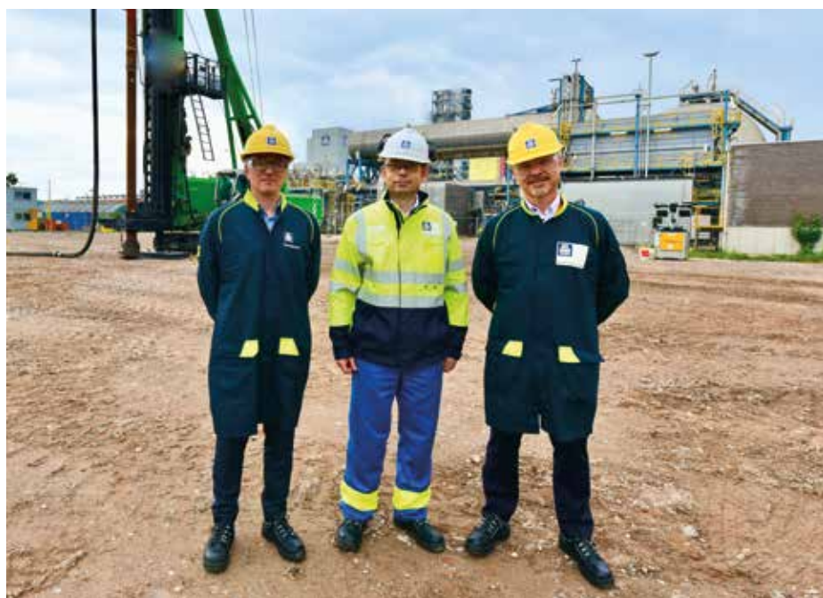
Igor Lavretsov (Project Manager Linde Engineering Dresden), Michael Schlaug (Vice President Yara Netherlands) en Jostein Tegle (Strategy & Market Director Northern Lights) hebben de eerste paal voor het Carbon Capture & Storage project geslagen op 22 mei 2024.
