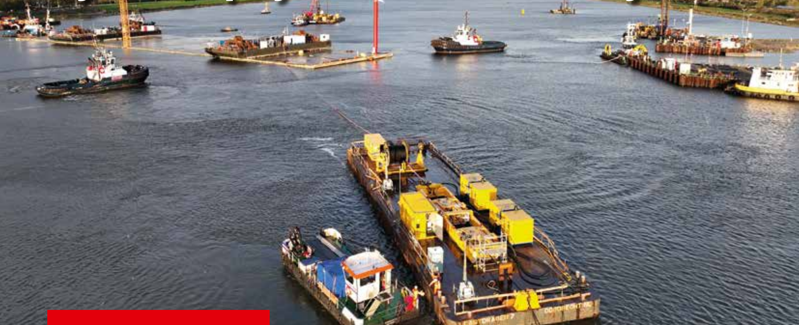
Pontons van Koninklijke Van der Wees werden ingezet bij het afzinken van de tunnelbuis voor de nieuwe Blankenburgverbinding.
