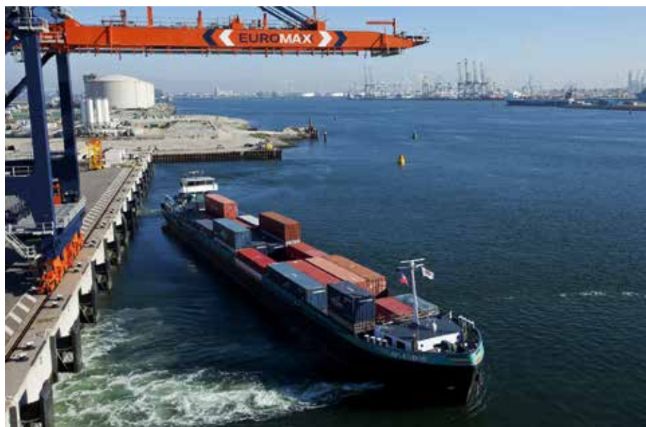
De containerterminals in Rotterdam moeten op termijn allemaal walstroomaansluitingen krijgen.
