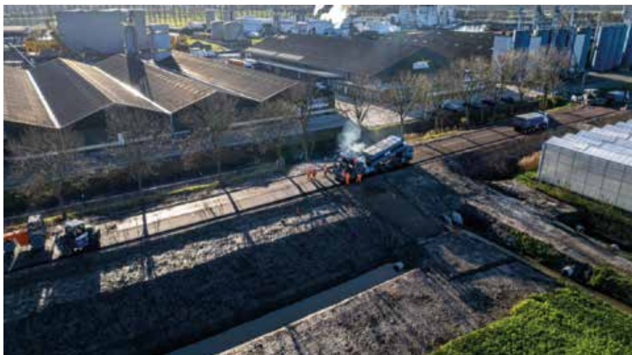
Dijkverbetering langs de Mark Dintel Vliet in West-Brabant
