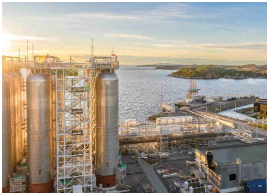
De CO 2 ontvangstinstallatie van Northern Lights in Øygarden. De CO 2 schepen worden hier gelost in opslagtanks. Vervolgens wordt de CO 2 vanuit deze tanks 100 kilometer uit de Noorse kust opgeslagen in lege gasvelden die bestaan uit poreus gesteente op 2,6 kilometer diepte in de zeebodem.
