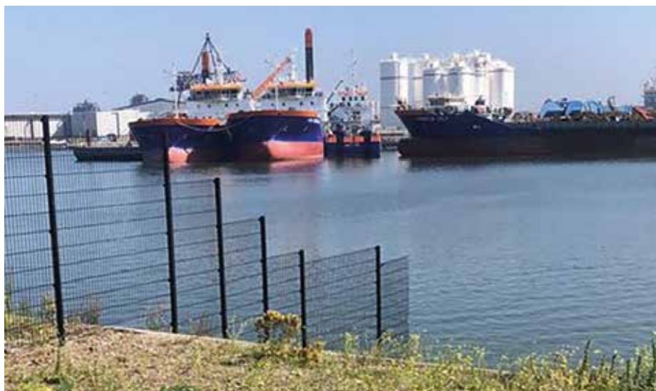
Extra hekwerk aan de kade van CCT Moerdijk.
