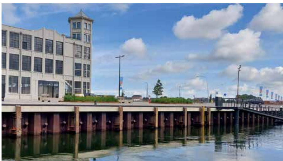
Waterbouwwerken Albionkade Vlissingen.
