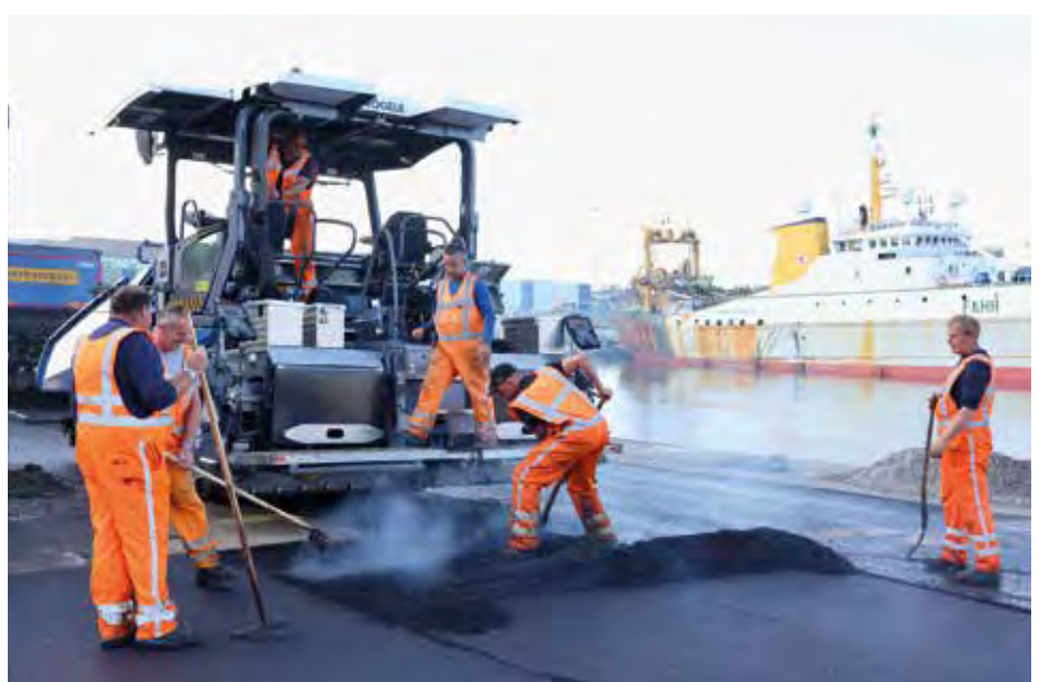
Herstel kadeverharding na aanleg walstroomvoorziening in de Haringhaven.
