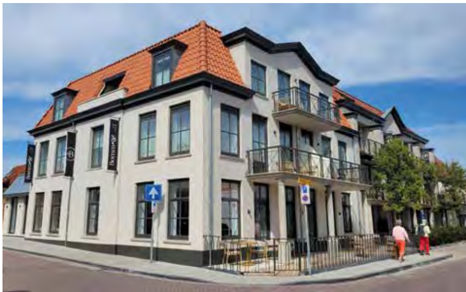
Hotel Bommeljé in Domburg is dit jaar helemaal duurzaam met nieuwe klimaatinstallaties.
