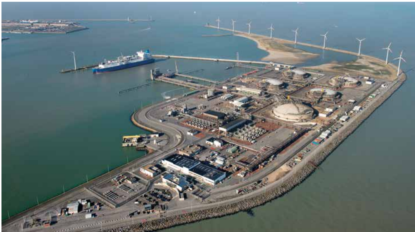
Fluxys LNG Terminal.
