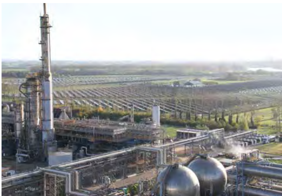
Op de voorgrond de Refining E-plant, op de achtergrond Solar Koegorspolder.
