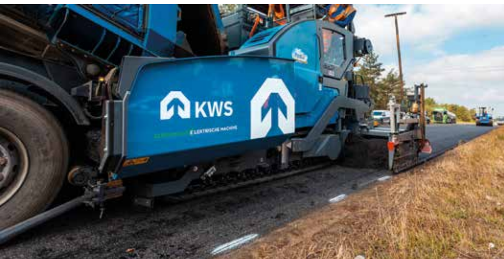
Innovatieve elektrische asfaltspreider.
