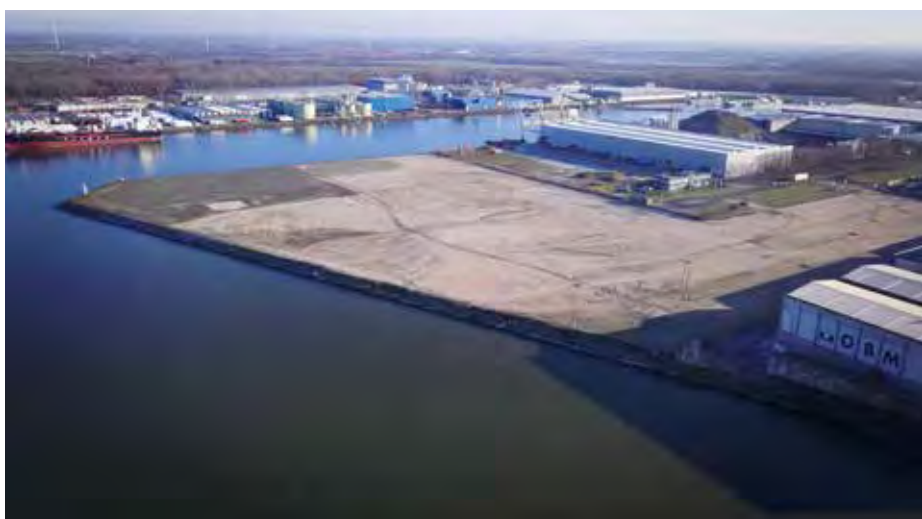
Het voormalige Tetra Pak-terrein is bouwrijp gemaakt voor een nieuwe kade.
