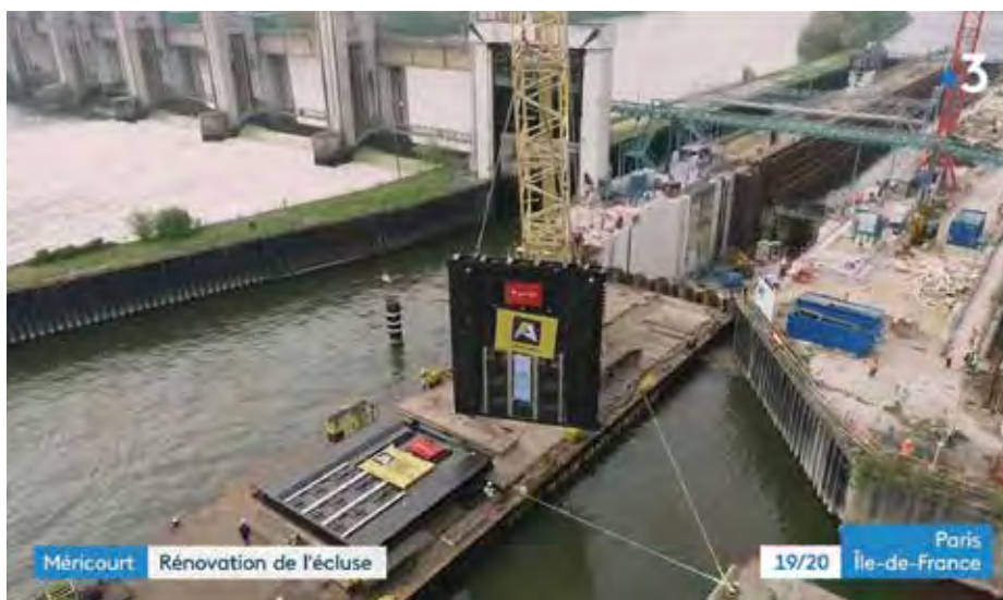
Plaatsen van een sluisdeur in Frankrijk in opdracht van Aertssen Kranen.
