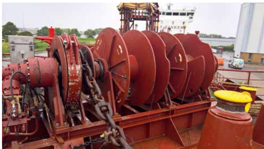
Timmerman Industrial Repairs had een week de tijd voor de totale revisie van een ankerspil van een chemicaliëntanker.
