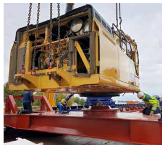
Met behulp van de onderwagen kan de graafmachine over de hele lengte en breedte van het ruim bewegen.
