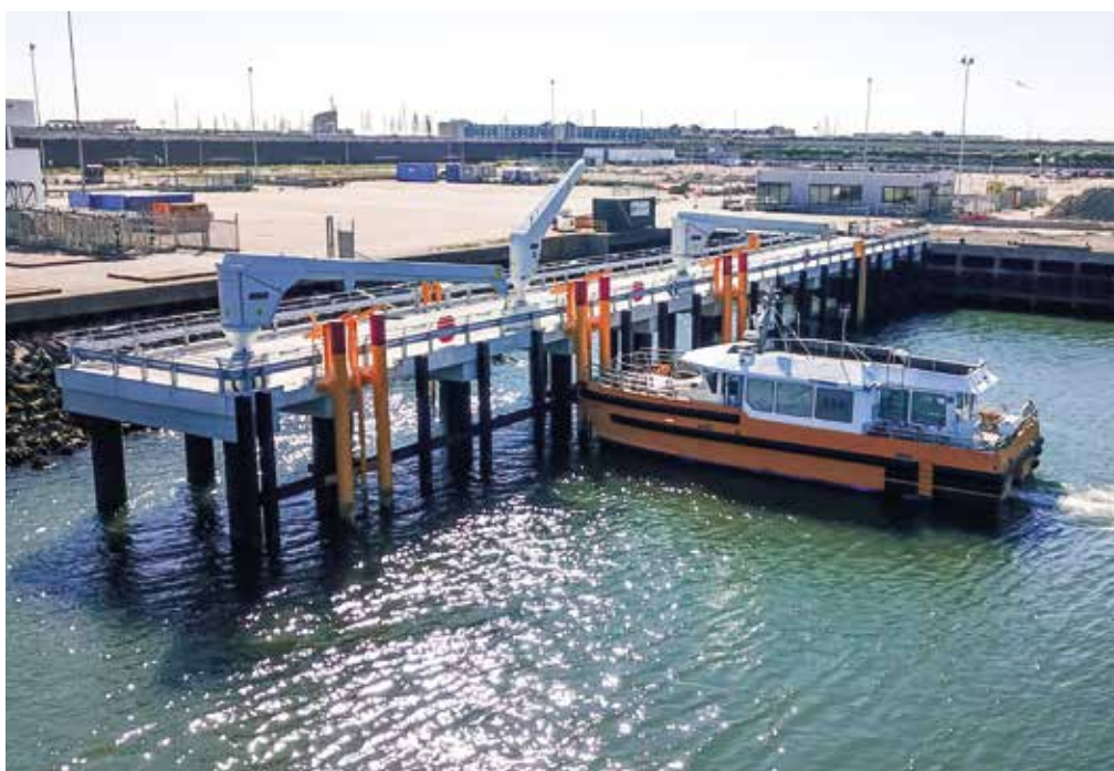
De aanlegsteiger in de IJmondhaven voor bouw en onderhoud van offshore windpark Hollandse Kust Zuid.
