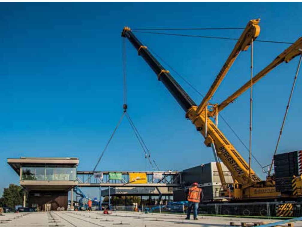
Tolplein Dordtse Kiltunnel.
