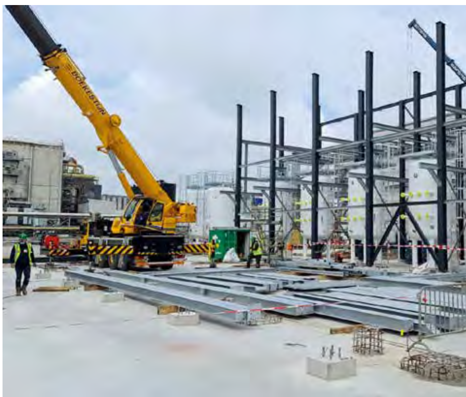
Bouw bedrijfshal Evides Industriewater in Antwerpen.
