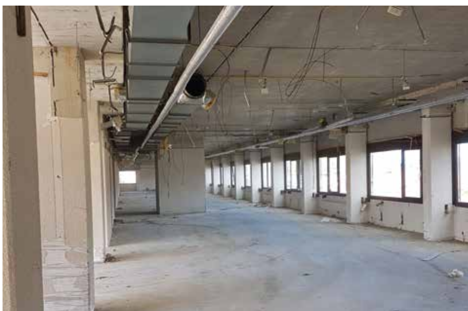
Te ontmantelen kantoorpand in Hilversum na demontage herbruikbare materialen.
