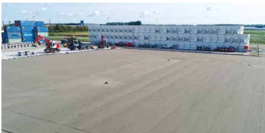
Wegen- en rioleringswerken Westdorpe.
