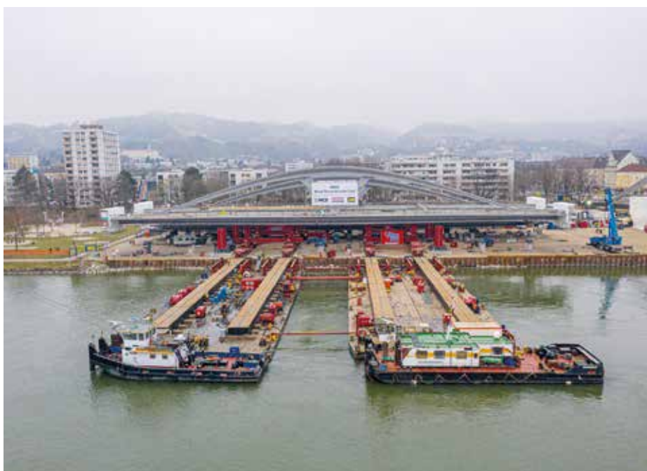
Plaatsing van een spoorbrug in het Oostenrijkse Linz.
