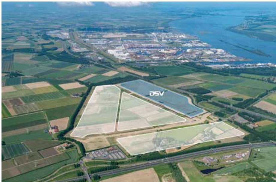
DSV vult de hele eerste fase in van Logistiek Park Moerdijk.
