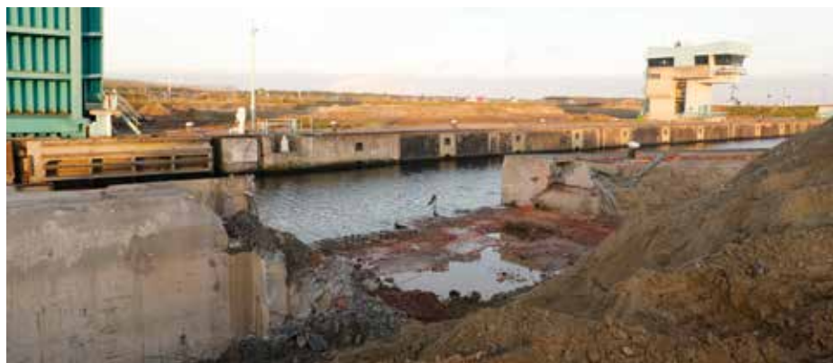
Sloop van de Middensluis.
