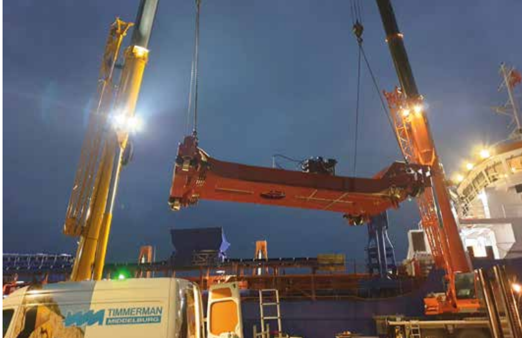
Plaatsing van de nieuwe, 23 ton zware onderwagen op het ruim van een nieuwe zand- en grindzuiger.
