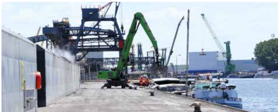
De kade van Heros Sluiskil is begin 2020 vernieuwd.
