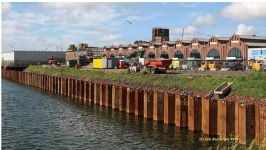
De Viskade voor de transformatie.
