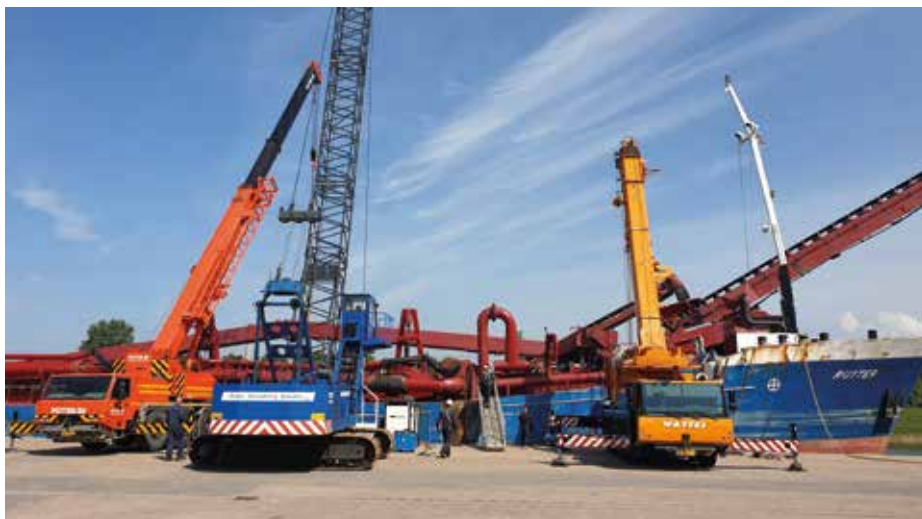
Een spoedreparatie aan een zandzuiger waarbij met behulp van drie kranen de laadgoot, waardoor het zand wordt geleid, is gerepareerd.
