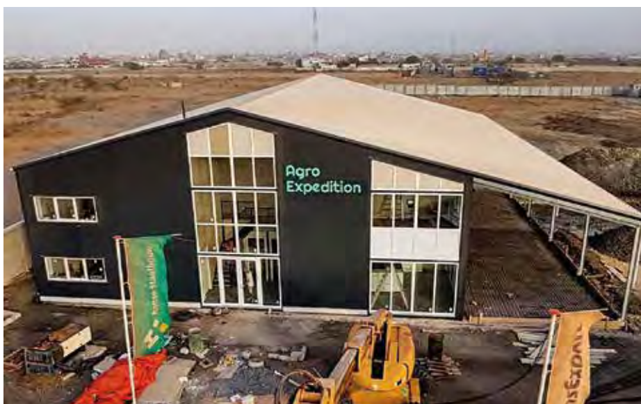
Opslag met kantoorruimte in Senegal.
