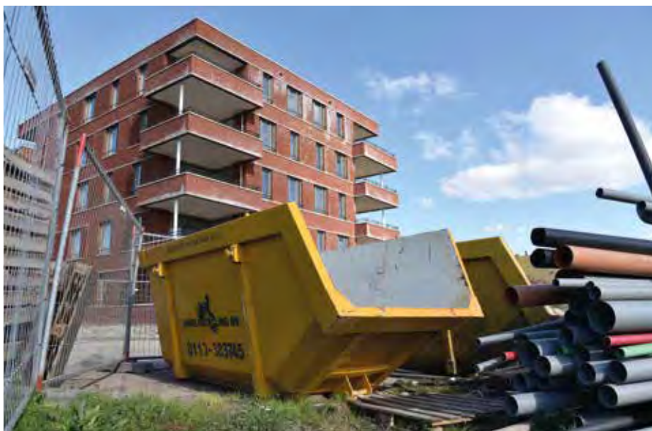
Sinke Recycling. Voor elke bouwplaats de juiste container.
