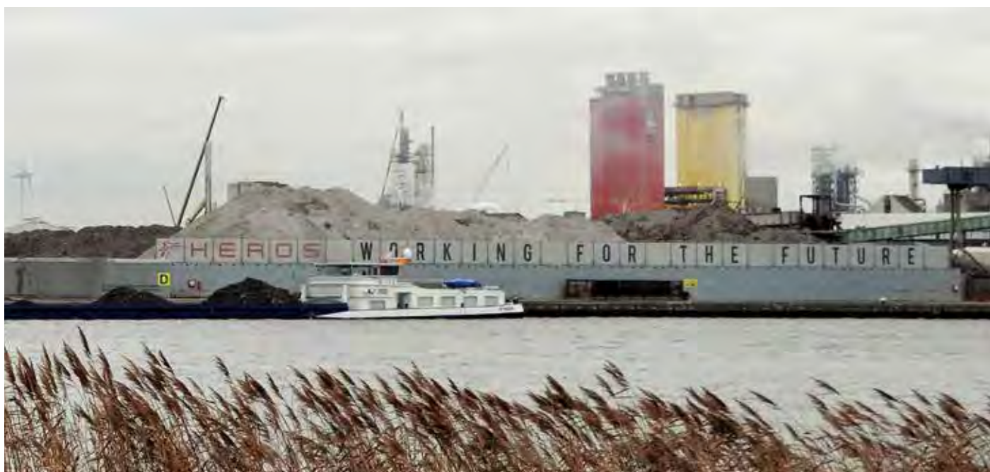
Het nieuwe kadeterrein van Heros is begin 2020 gerealiseerd.
