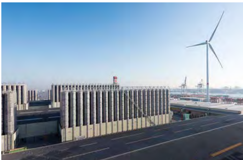
Katoen Natie Bulk Terminals in Kallo (Waaslandhaven).
