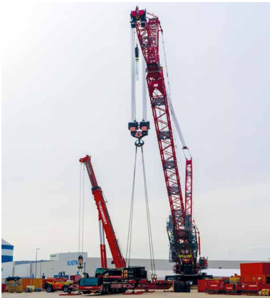
De baanbrekende kraan Focus 30 is opgebouwd en getest bij Mammoet in Westdorpe.
