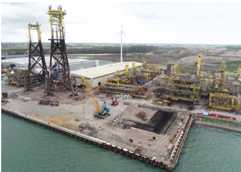
Recente luchtfoto van de terminal van Sagro in Vlissingen Oost.
