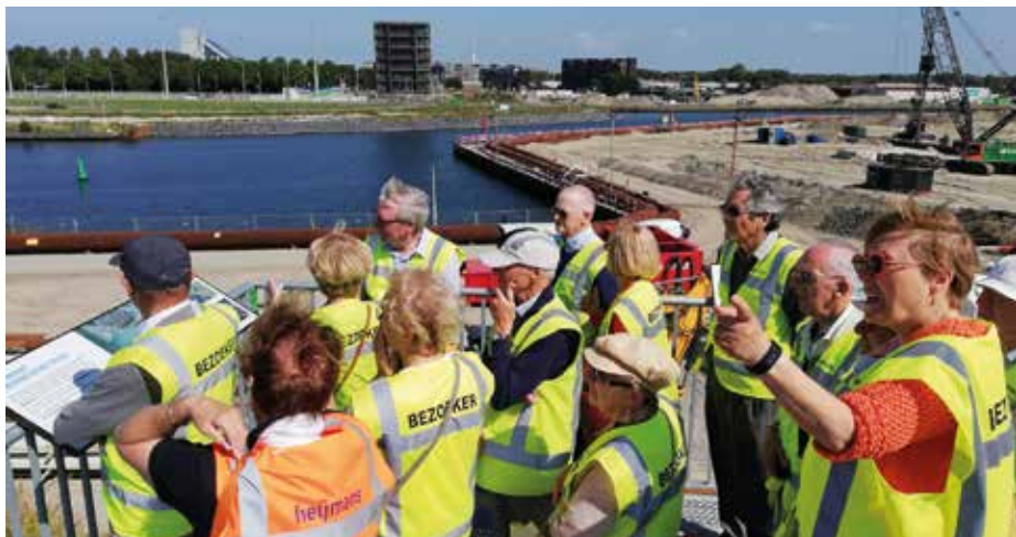
Rondleiding bij de bouw van De Nieuwe Sluis (voor het Corona tijdperk).
