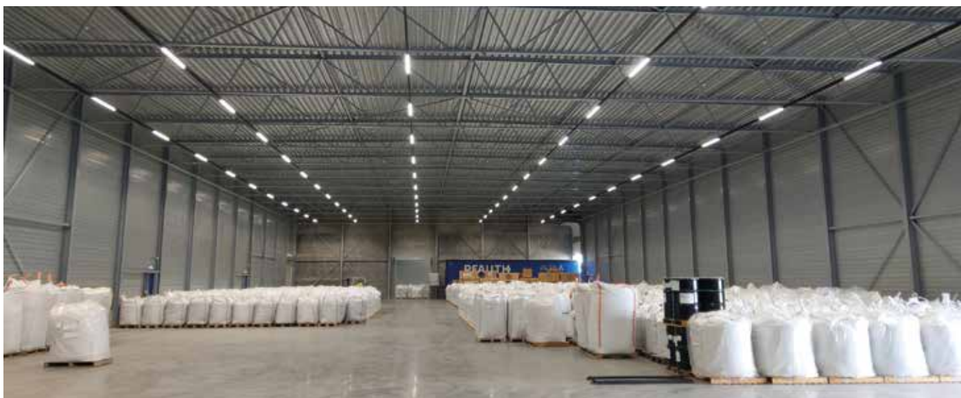
De nieuwe (extra) opslagloods is onlangs opgeleverd).
