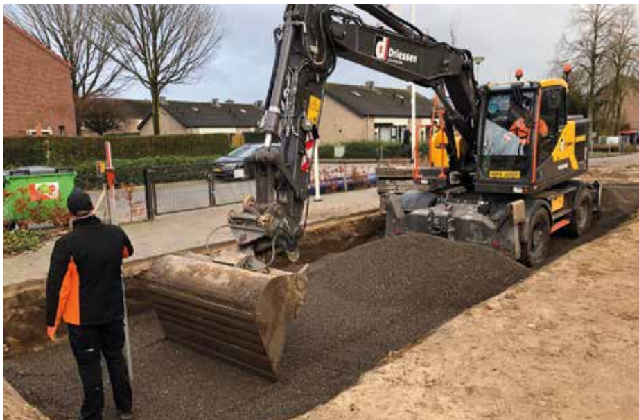
Toepassing van DrainMix® op het schoolplein van Basisschool Onder de Wieken in Meterik.
