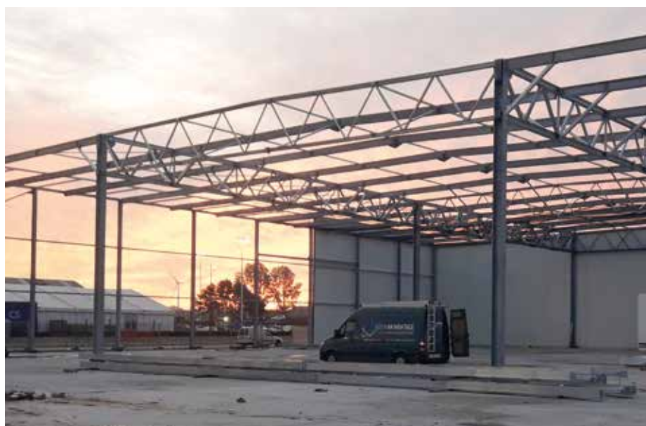
Staalconstructie voor een diepvriesloods in Gent.
