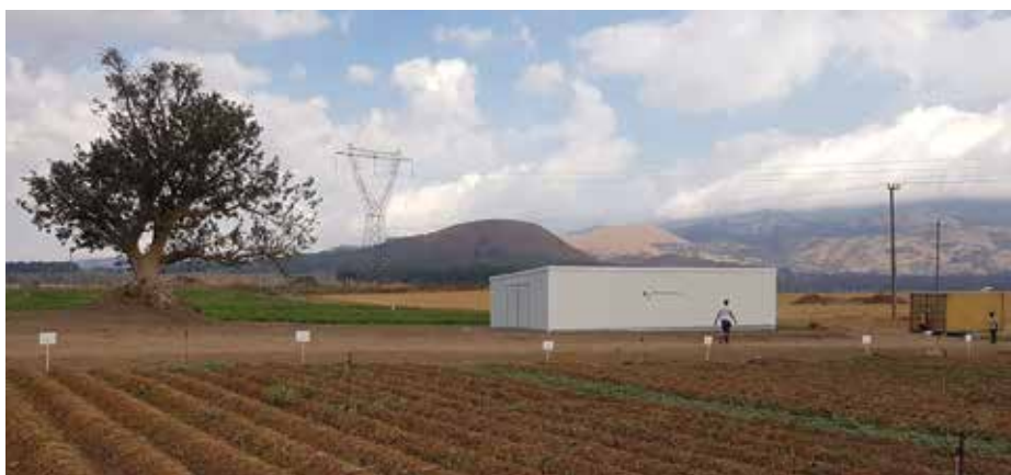
Opslagloods in Tanzania om kleine boeren te ondersteunen.
