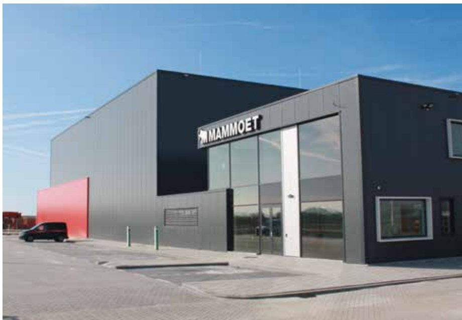
De nieuwbouw van Mammoet aan de Autrichehavenweg in Westdorpe.
