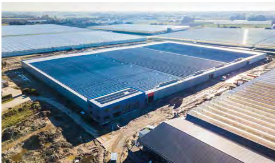
Nieuwbouw caravanstalling en belevingscentrum in Tinte.
