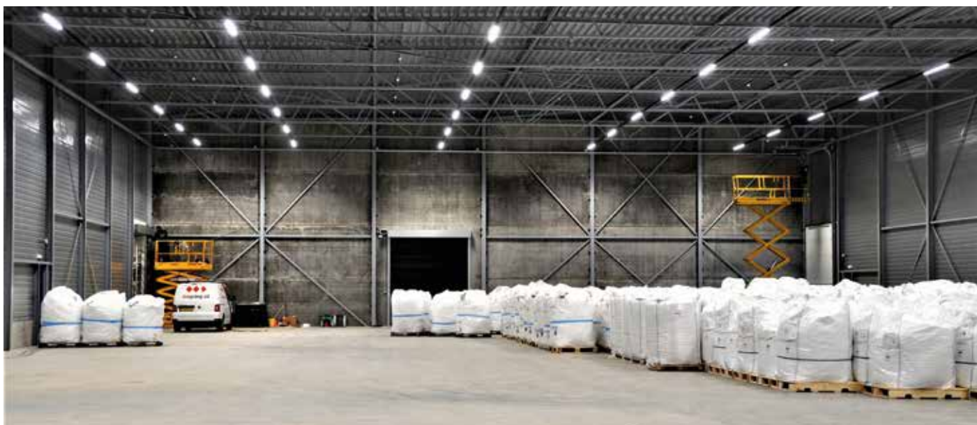
De nieuwe (extra) opslagloods is recentelijk opgeleverd.
