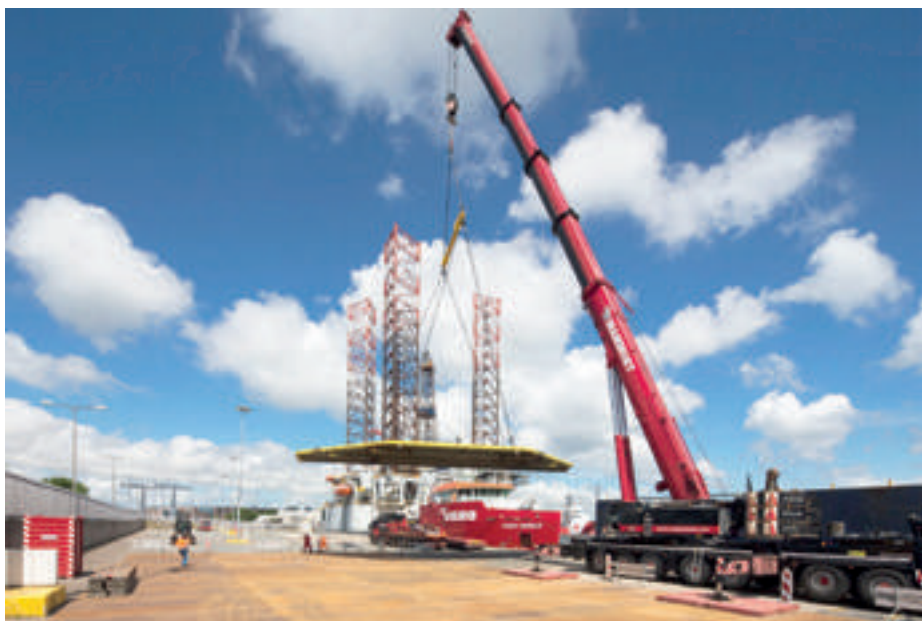
Werkzaamheden voor Nederlandse Aardolie Maatschappij (NAM) in Port of Den Helder.
