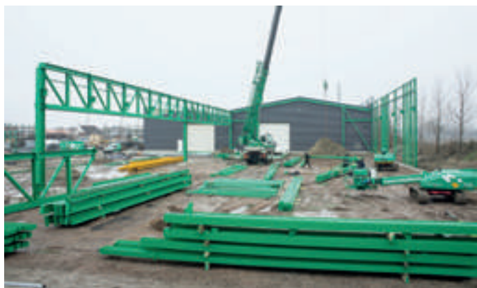
Uitbreiding van de productiehal bij Hanse Staalbouw.
