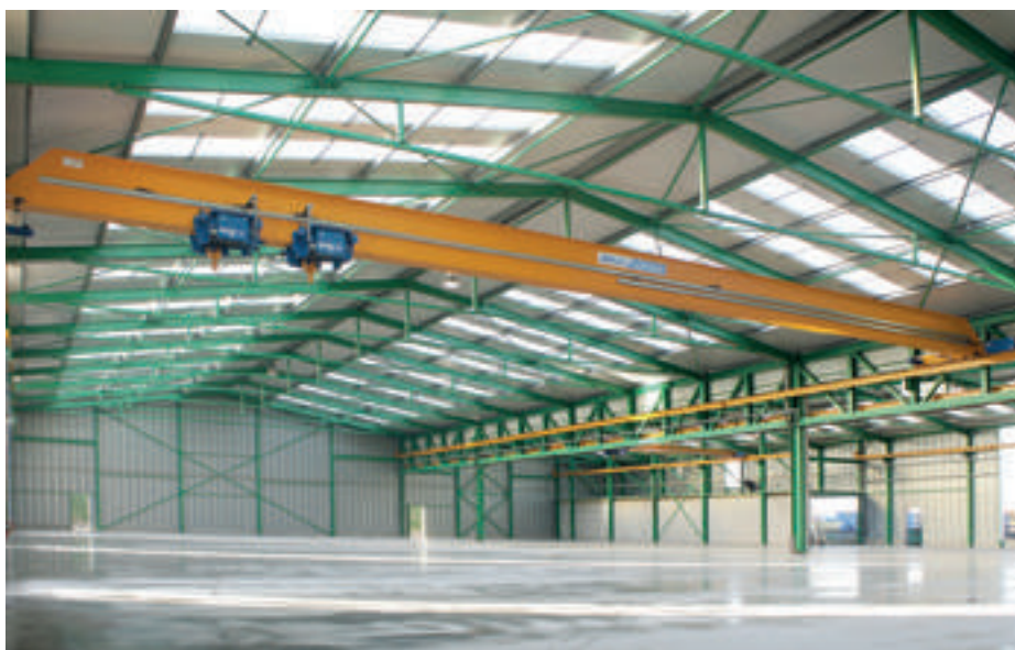
De hal voor de nieuwe markeer-/boor-/zaagstraat
