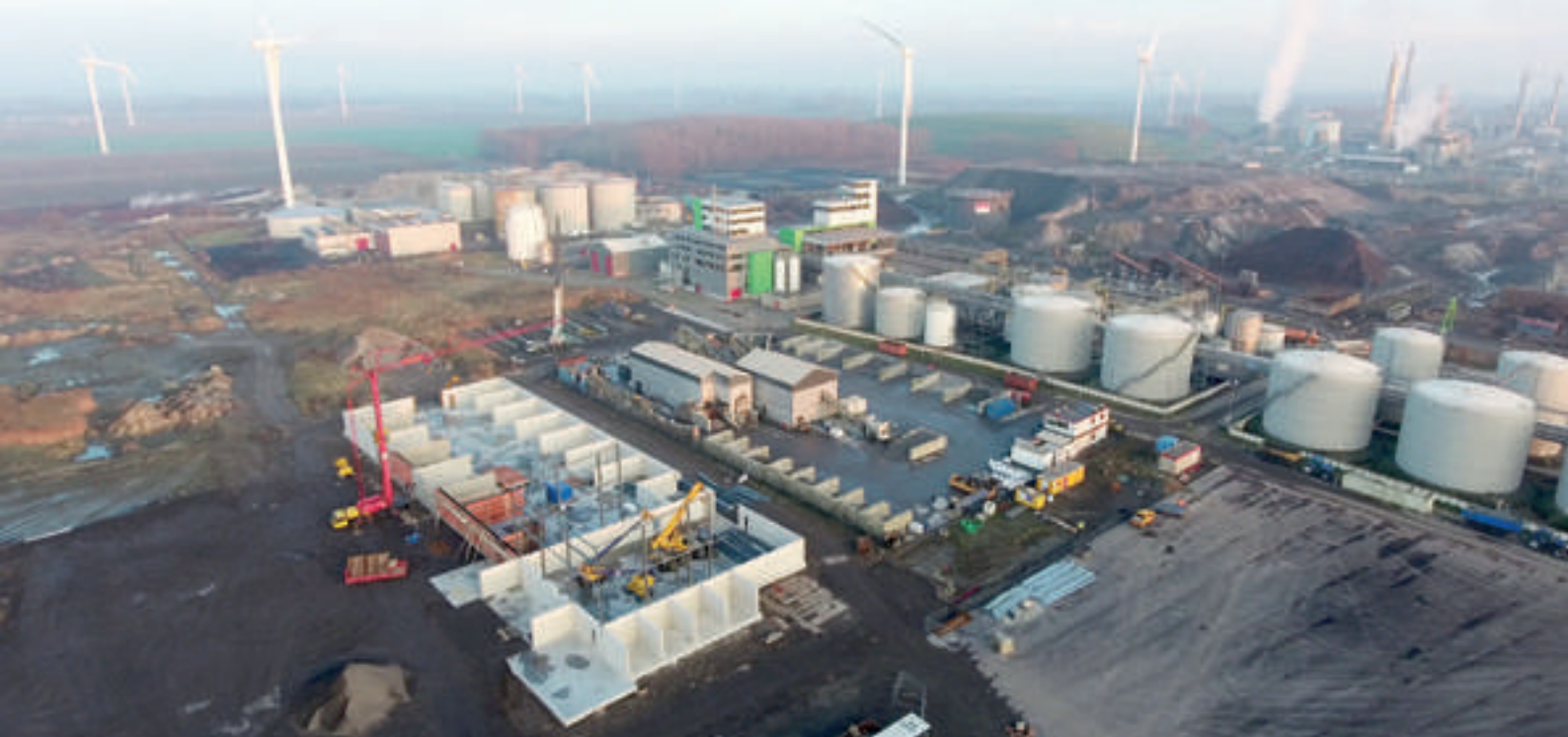
Luchtfoto van de bouw van de non-ferro fabriek
