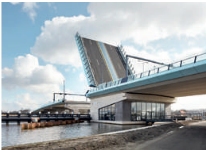
De Amaliabrug over de Gouwe, een belangrijk onderdeel van het project Parallelstructuur A12
