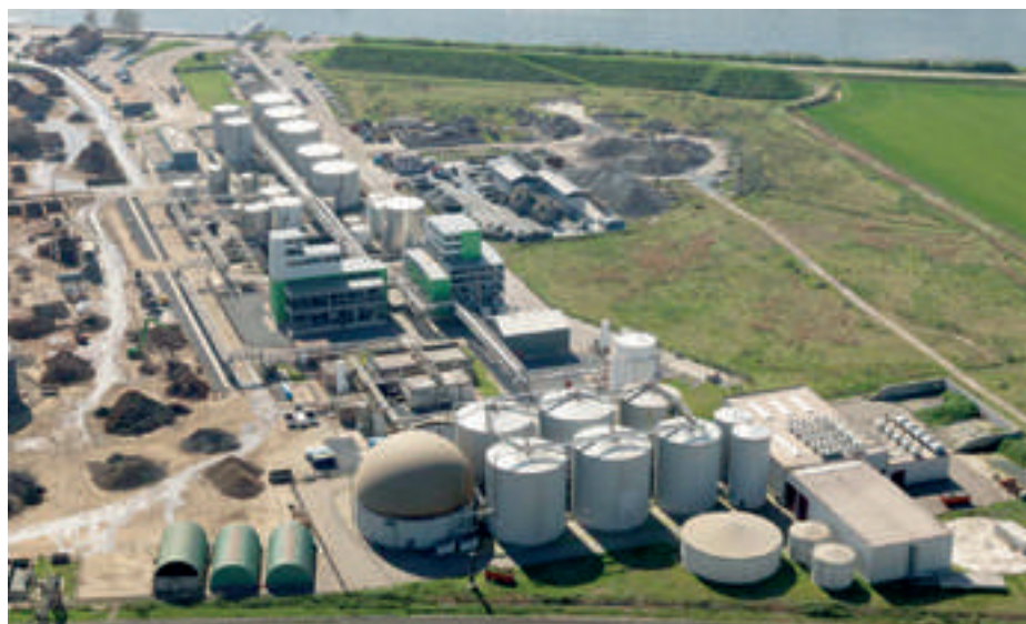
Luchtfoto van het Eco Park Terneuzen met op de voorgrond de nieuwe Tank Terminal Sluiskil.
