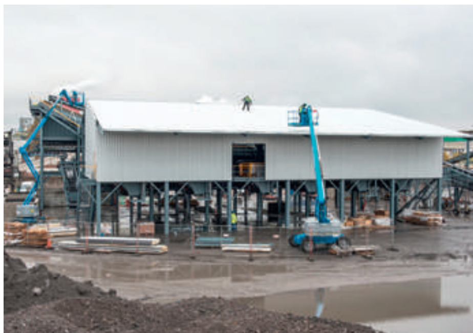
Nieuwbouw van de opwerking
