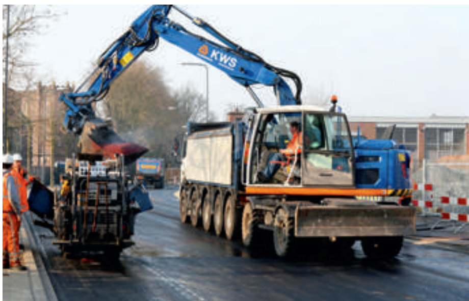
Asfalteringswerkzaamheden Boschdijkstraat in centrum 's-Hertogenbosch
