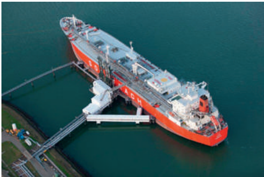
HDV heeft voor Vopak in Vlissingen Oost de laad- en los steigers gebouwd voor de gasschepen.
