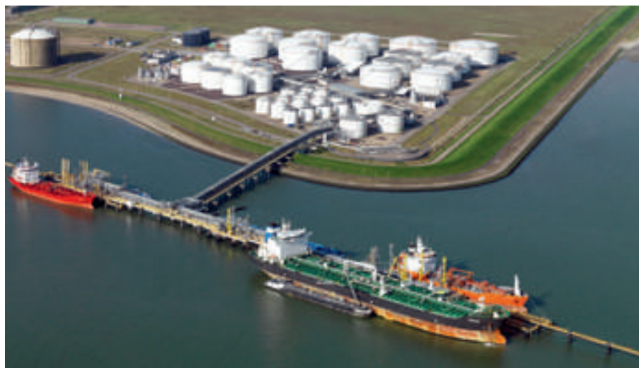
Uitbreiding opslagcapaciteit Oiltanking
