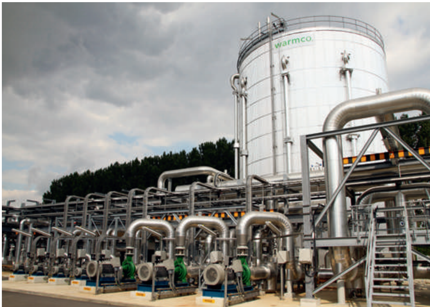
Yara levert restwarmte en CO 2 aan de naastgelegen glastuinbouw via buisleidingen
