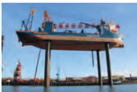
De Aeolus op hoge poten bij VDS Offshore Construction Terminal in Nieuwdorp
