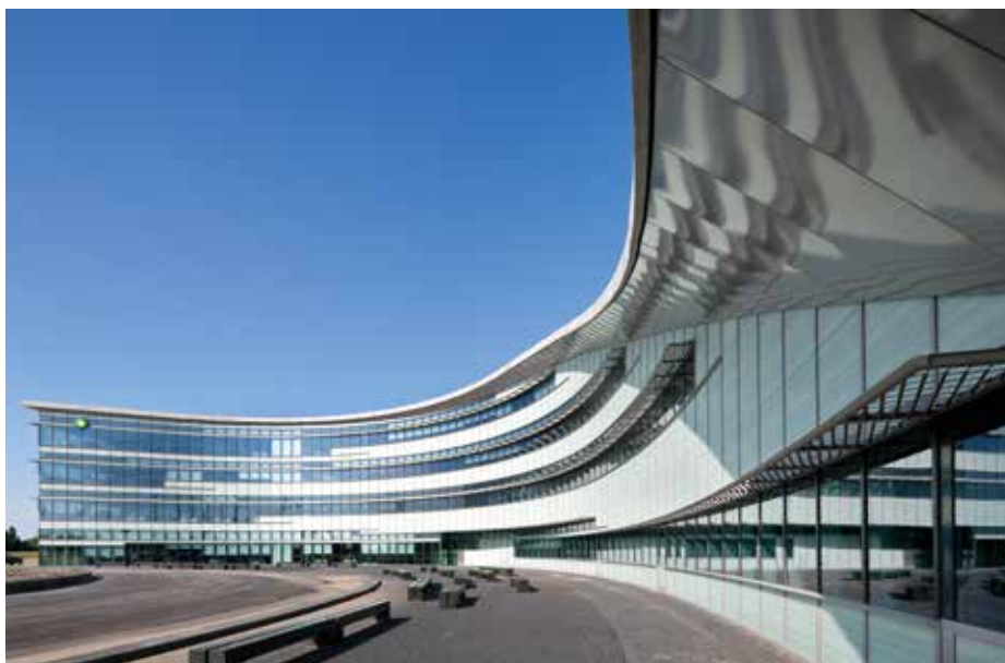
Het nieuwe hoofdkantoor van BP.
