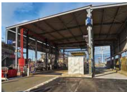
De LNG-terminal in Zeebrugge beschikt sinds eind vorig jaar over twee trucklaadstations. (Copyright Fluxys Belgium)
