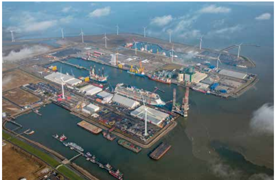
In de Eemshaven werd voor General Electrics de pre assemblance van 66 Haliade 150-6MW turbines verzorgd voor het Merkur Offshore Windpark.
