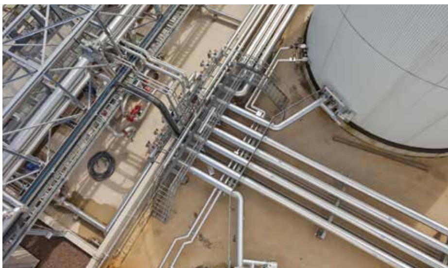
Om chemieproducten te kunnen opslaan is alle leidingwerk in roestvrijstaal uitgevoerd.
