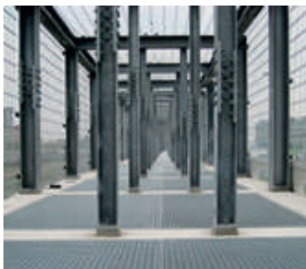
800 meter leidingbrug langs de A15 nabij Rotterdam
