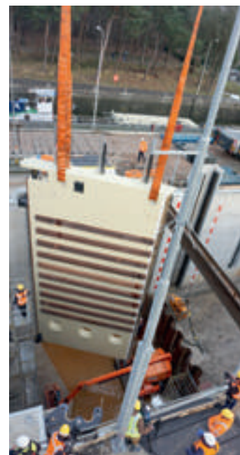
Installatie van de grootste composiet sluisdeuren ter wereld
