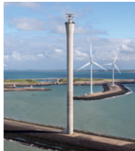
Radartoren op Neeltje Jans, voorzien van stalen relingwerk en kraaiennest op 110 meter hoogte
