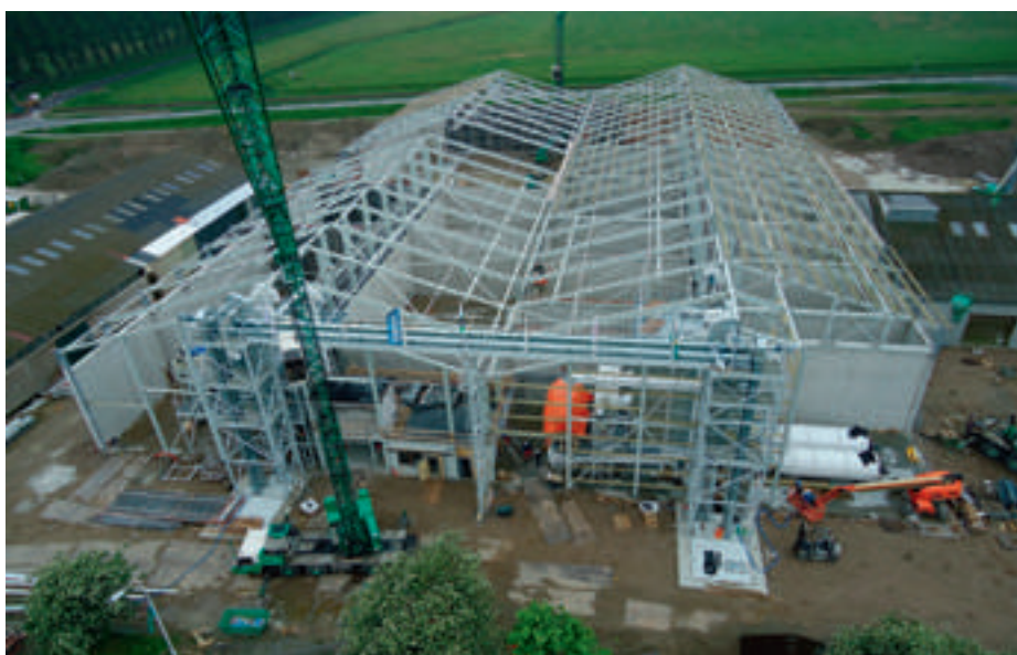
Graanloods in aanbouw te Westdorpe
